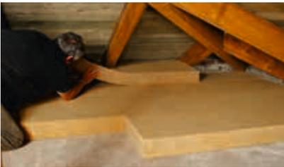
Les panneaux isolants STEICO<sup>top</sup> permettent de recouvrir rapidement de grandes surfaces. Si deux couches d'isolants doivent être posées, il est conseillé de les poser à joints décalés.
